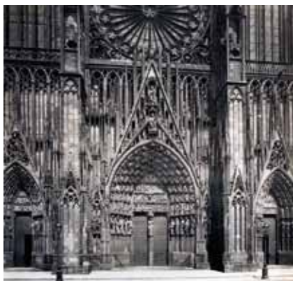
Façade ouest, portail central / Westfassade, Hauptportal / West front, main portal
