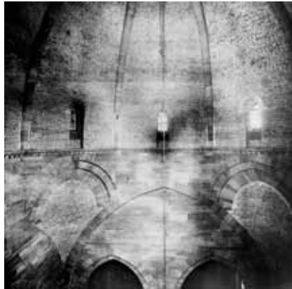
Coupole de la tour de croisée / Kuppel des Vierungsturmes / Cupola of the crossing tower
