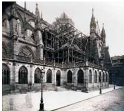
La cathédrale côté sud, échafaudages en bois / Südseite des Münsters, Holzgerüste / South side of the cathedral, wood scaffolding
