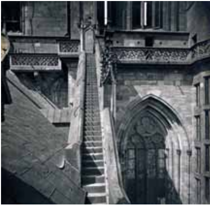
Escalier situé entre la nef et le massif occidental (côté nord) / Treppe vom Langhaus zum Westmassiv / Stairs between the nave and the west front
