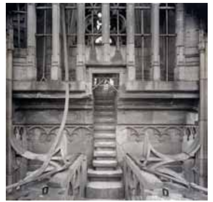
Escalier menant à la base de la flèche / Treppe zur Basis der Turmspitze / Stairway leading towards the base of the spire
